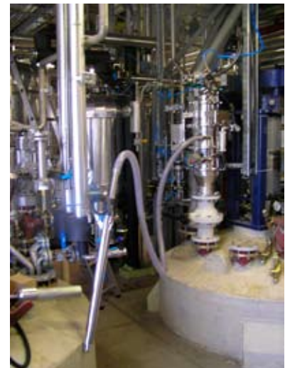
Pneumatikus szállító berendezés üzembe helyezés közben
