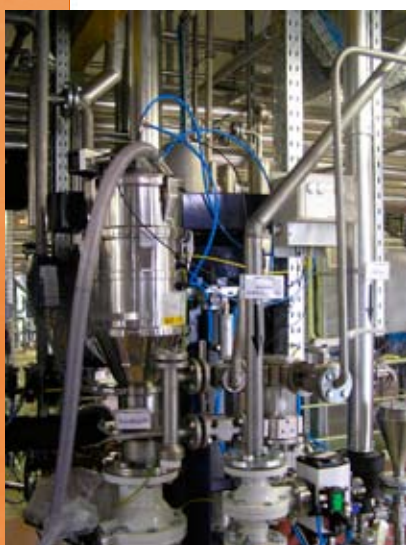
Felújított pneumatikus szállító berendezés üzembe helyezve
